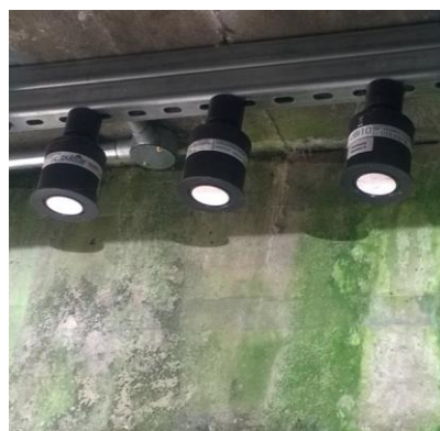
3台のdBi HARTトランスデューサ (水門水位モニタリング)
